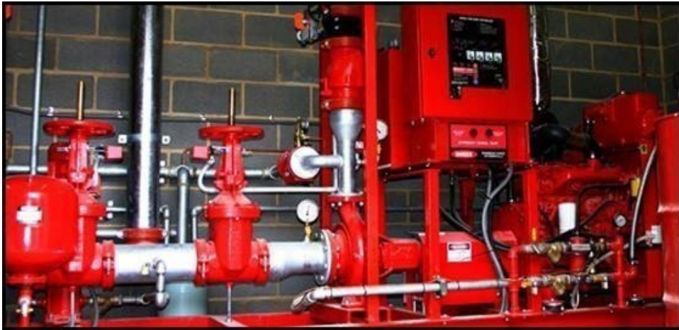
صورة ٤٩: مثال على أنظمة إطفاء الحرائق (ذات المضخات المتوازية)
