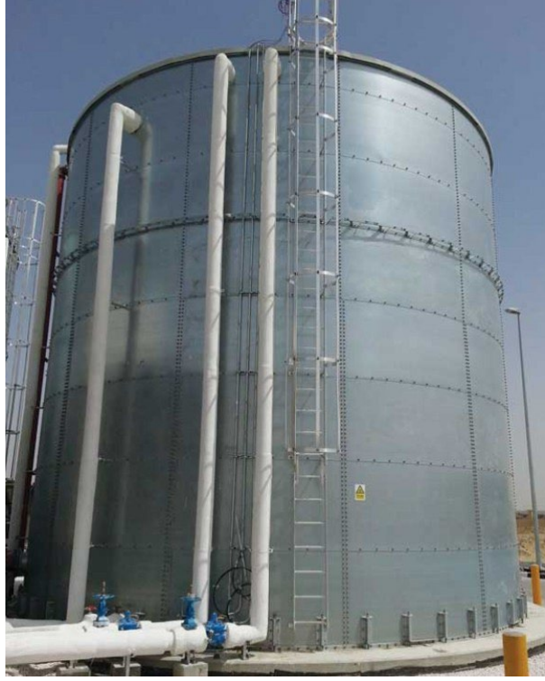
صورة ١٢ خزان ماء مصنوع من الفولاذ الكربوني
