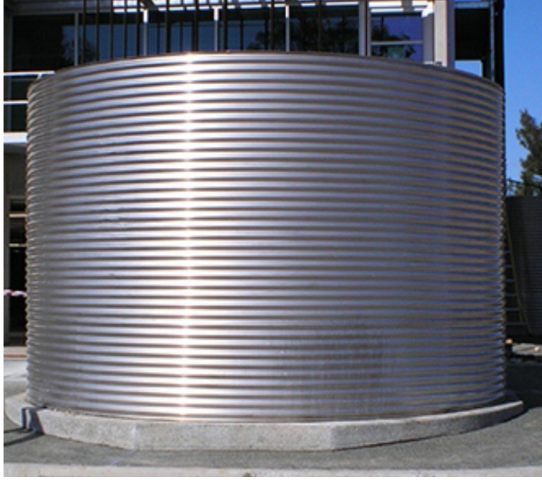
صورة ١٠: خزان ماء مصنوع من الحديد المموج
