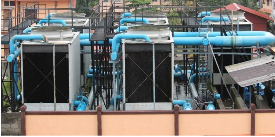
صورة ٣٠: معدات التكييف المركزي
